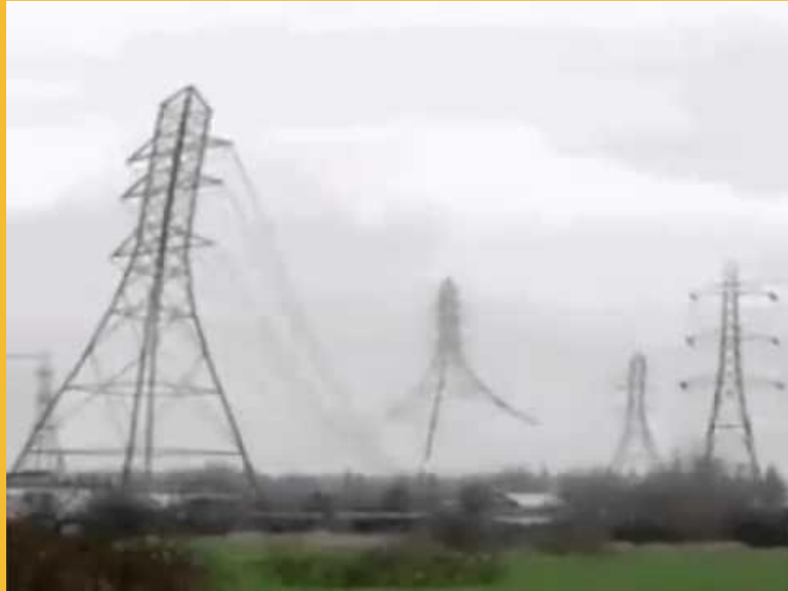
Torres eléctricas descontroladas
